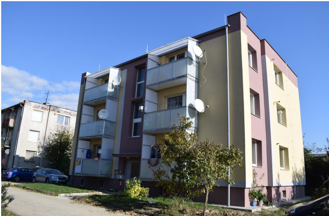
Obr. 3 Komplexná obnova BD Turany, ulica Osloboditeľov
