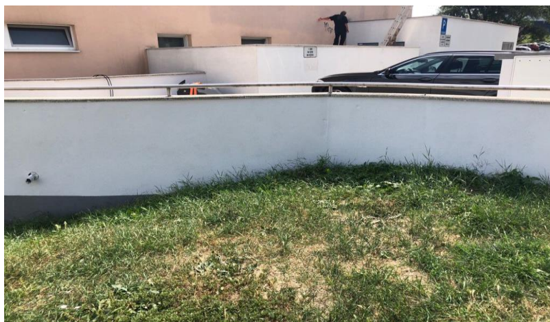
Popis fotografie: Obvodový múrik po kompletnej dezinfekcii
