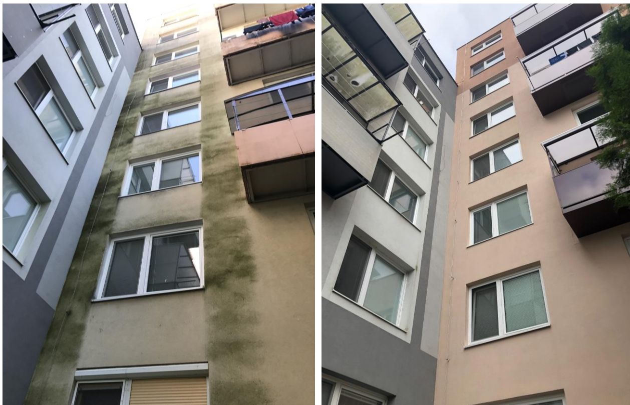
Popis fotografie: Celková sanácia povrchu fasády vrátane výmeny balkónových konštrukcií
